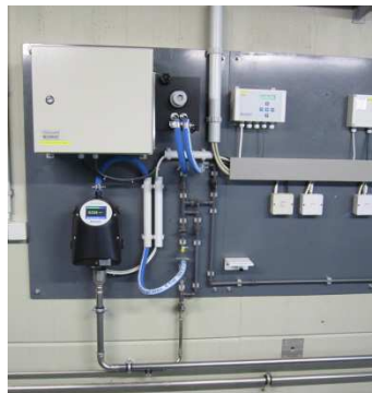
图 4：在线水中油监测仪 OilGuard，闭合取样测量的流通池
