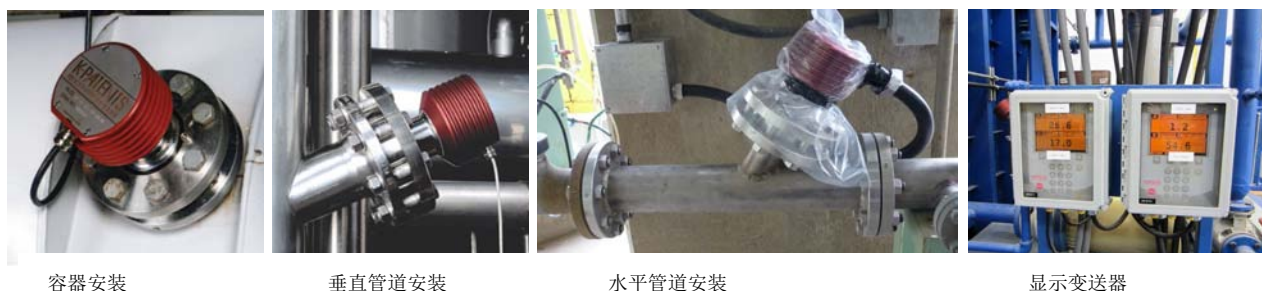
图 10 现场安装应用照片
